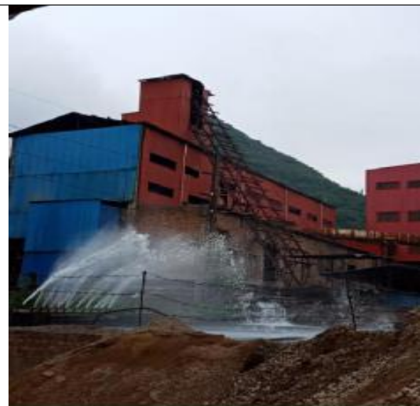
冷却循环水池
